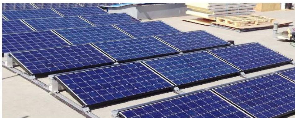
Fig. 57 – Dettaglio delle modalità di posa su cavalletto dei pannelli FV a tetto
